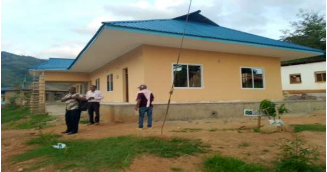
Picha No. 02: Inaonesha ujenzi wa Jengo la Utawala
