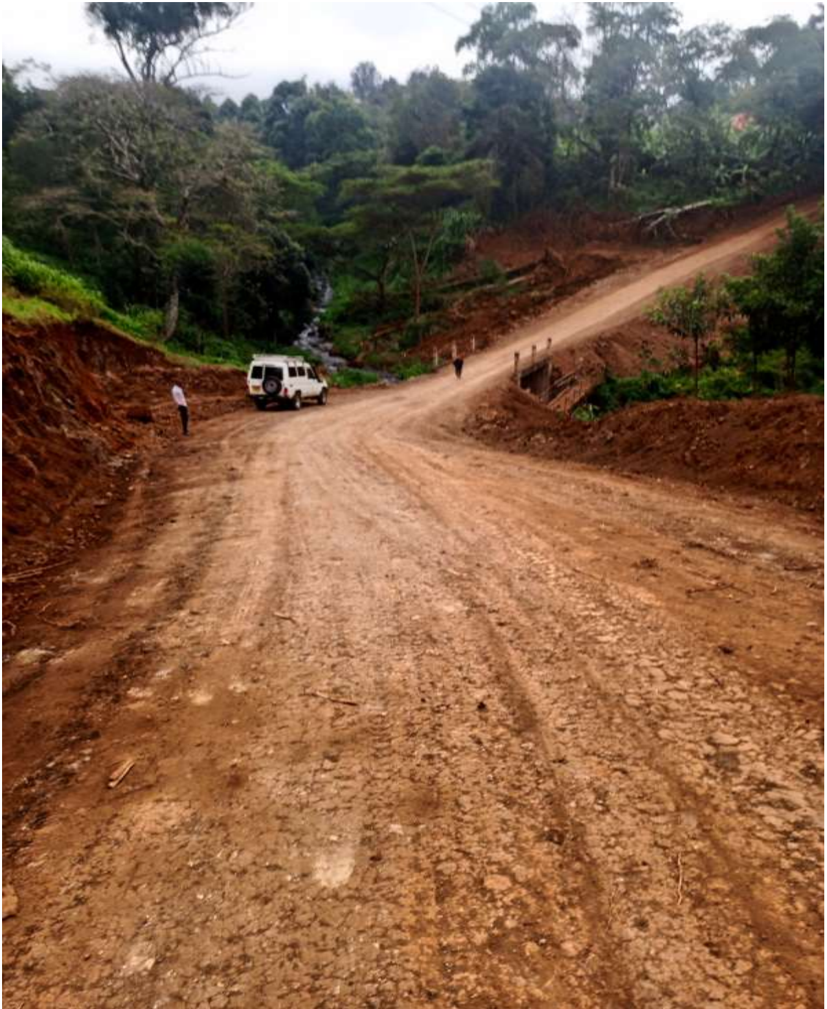
Picha Na. 5 Daraja baada ya Utekelezaji wa mradi
