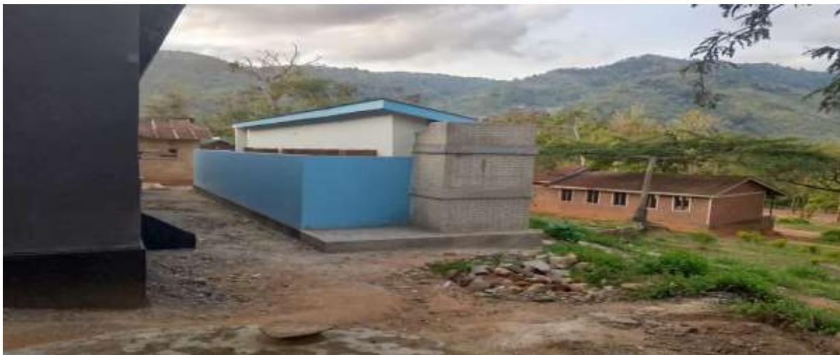
Picha No. 03: Inaonesha ujenzi wa matundu 12 ya vyoo vya wanafunzi wasichana
